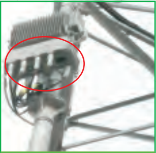
跳线连接到射频单元的RRU接头(红圈处)已使用CNCST-2进行防水处理
